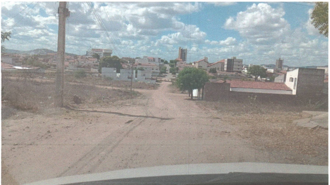
Extensão da rua sem pavimentação até o limite da via férrea NO Jardim Lacerda, cerca de 500 metros
